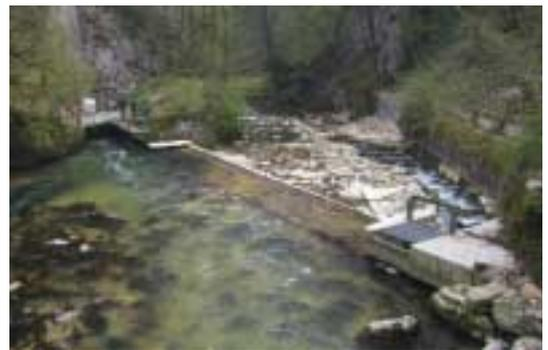
Abb. 4.6.4: Wasserfassung in der Schüss mit Fischtreppe (rechts) und Ableitungskanal (links).
