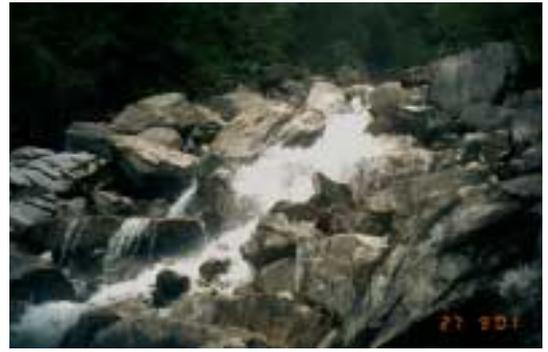
Abb. 4.5.6: Steilster Abschnitt der Restwasserstrecke mit Blockrampe während der Sommerdotierung am 27.9.01.  $Q = 350$  l/s.
