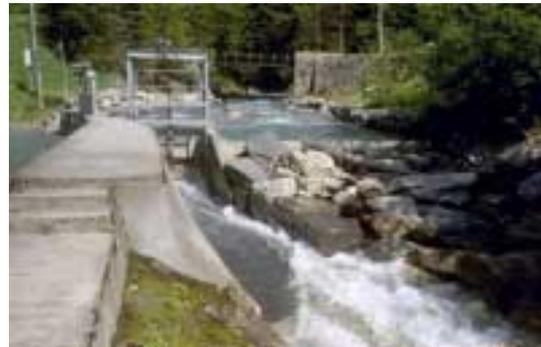
Abb. 4.5.4: Wasserfassung im Flembach am 20.6.01. Links der Mitte ist die Dotierwasseröffnung (Dotierung: 350 l/s) und ganz links das Fassungsbecken zu sehen.
