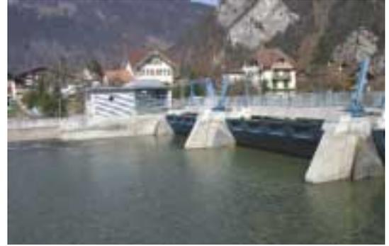
Abb. 4.3.4: Wehranlage mit Dotierkraftwerk (Mitte links) und Fischtreppe (hinter Dotierkraftwerk; nicht sichtbar) an der Aare in Interlaken.
