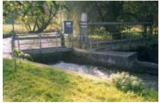
Abb. 4.1.4: Wasserfassung im Aabach mit Wehr und Ausleitungskanal.
