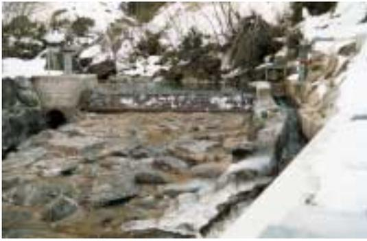
Abb. 4.8.3: Wasserfassung des Vorderen Schächen. Rechts ist die Dotiereinrichtung sichtbar.
