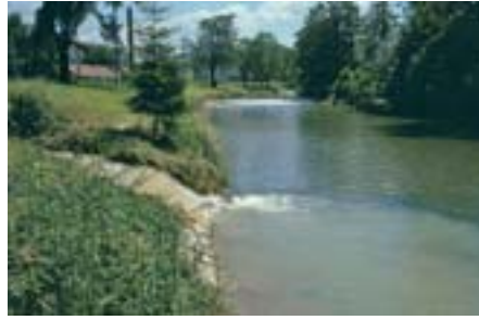
Abb. 20: Für gewisse Arten unpassierbare Barriere im unmittelbaren Mündungsbereich des Seitengewässers (Töss mit Seitengewässer)
