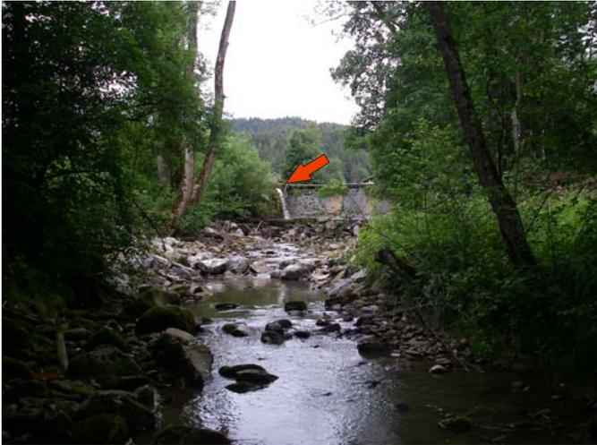
**Abbildung 24: Blick auf das Tosbecken und die Reswasserstrecke, der Wasserstrahl kommt aus der Spülrinne, hinter dem Fotografen mündet auf der rechten Seite die Wanderhilfe in die Argen**
