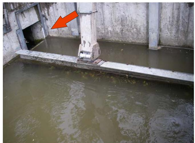
**Abbildung 23: Rechen, Rechenreiniger und Spülrinne am Kraftwerk Schüttentobel – Ableitung der Fische durch die Blende nach links.**
