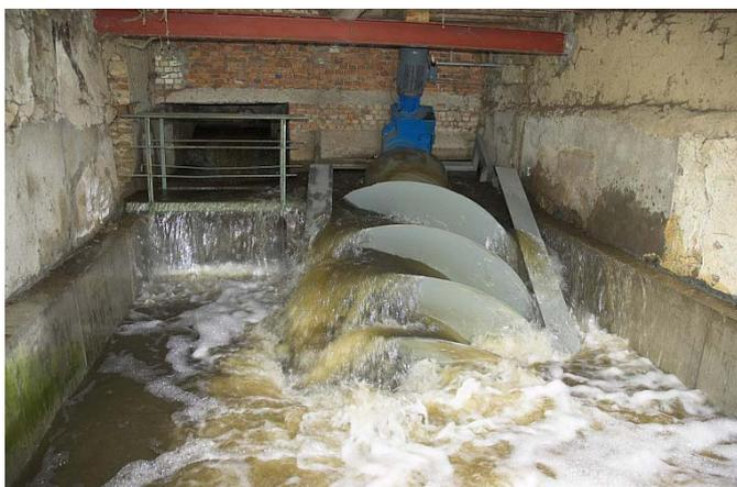
**Abbildung 82: Vollständig ins Unterwasser eingetauchte Wasserkraftschnecke**
