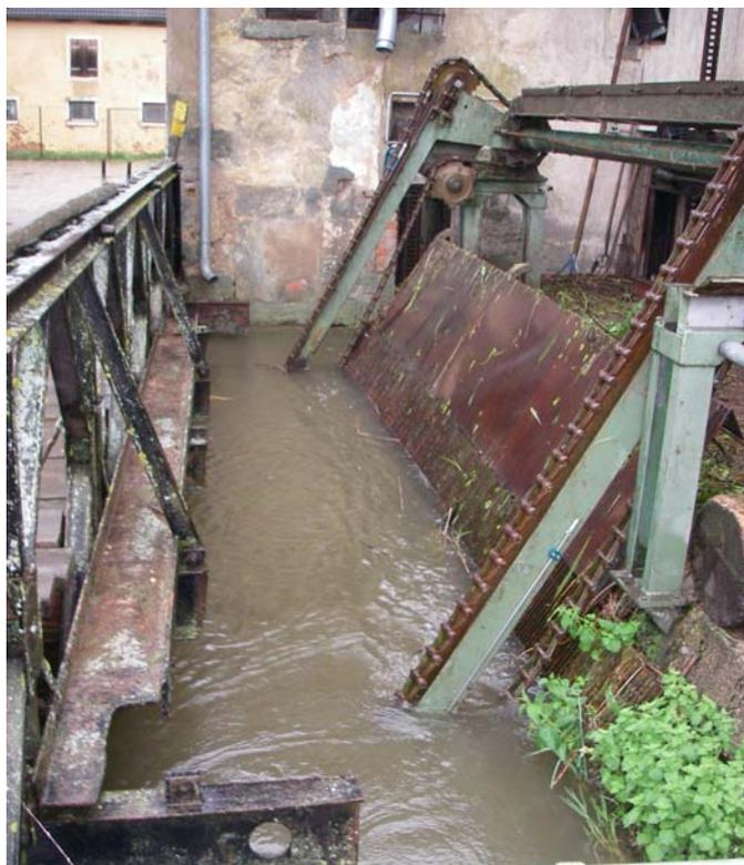
**Abbildung 16: Rechen und Rechenreiniger an der Gugelmühle / Wörnitz**
