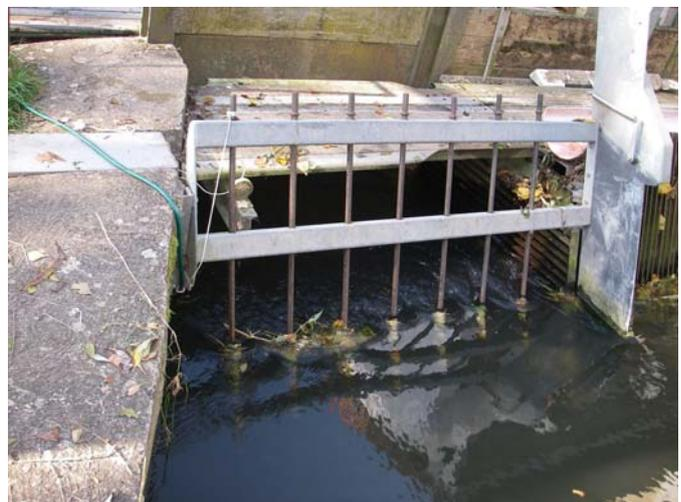
**Abbildung 36: Grobrechen Wasserkraftschnecke vertikal ca. 20cm.**
