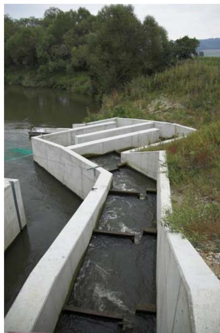
**Abbildung 87: Vertical-Slotabschnitt der Wanderhilfe am Rottaler E-Werk**
