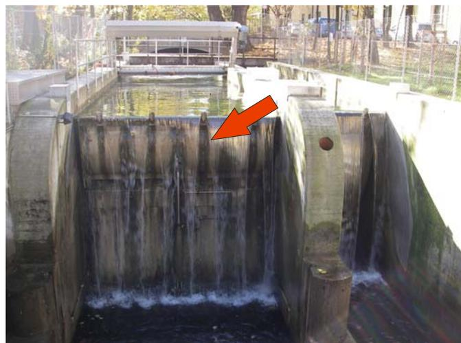
**Abbildung 42: Unterwasseransicht Muffathalle (links Rechengutklappe - rechts Notschütz)**
