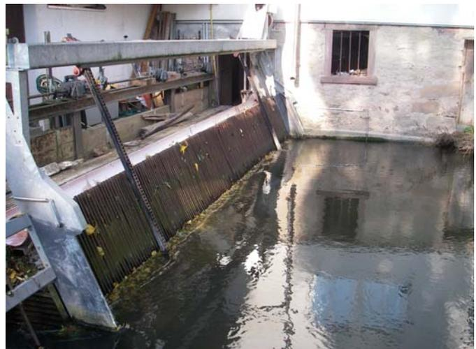
**Abbildung 35: Rechengement Wasserräder Rödtermühle (ca. 30mm).**
