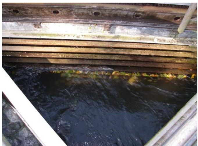
**Abbildung 37: Horizontaler Rechen vor der Wasserkraftschnecke.**
